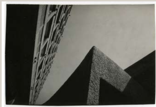
La maison du Brésil (Le Corbusier), Paris, 1958 Tirage d'époque par contact
